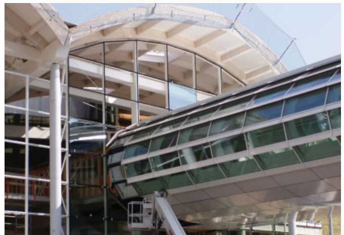
Dieses Gebäude wurde im Außenbereich mit HENSOTHERM® 3 KS F90 AUSSEN beschichtet (Foto: Rudolf Hensel)
